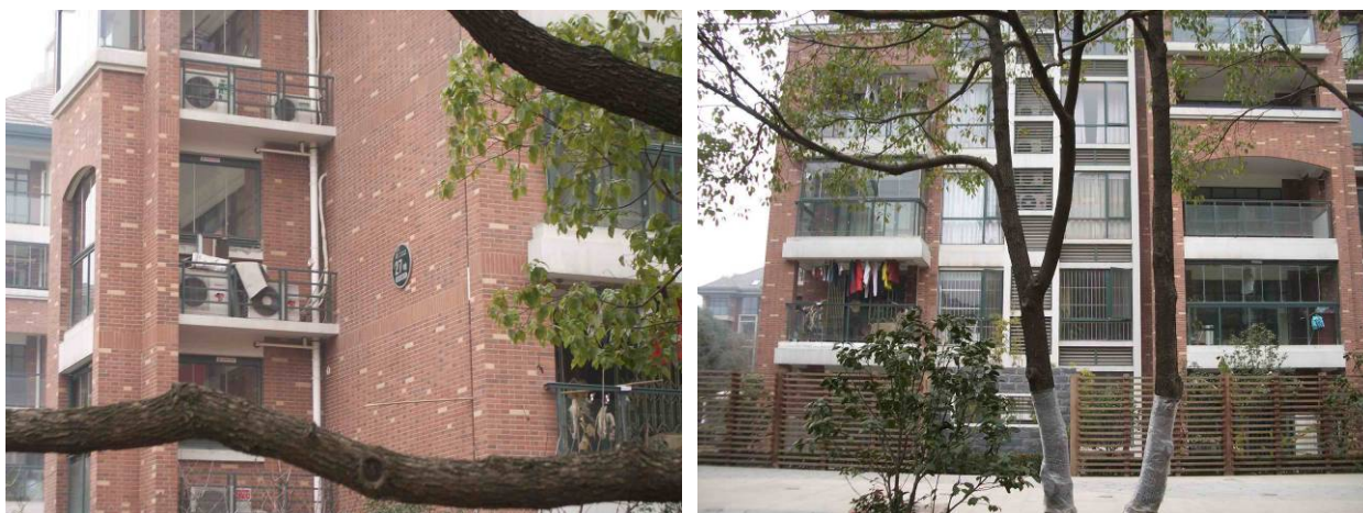
住宅楼，合肥，2007 年——每个房间均采用分体空调来采暖和制冷
